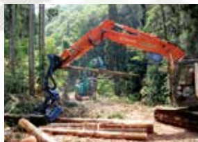
間伐材の搬出作業の様子。
