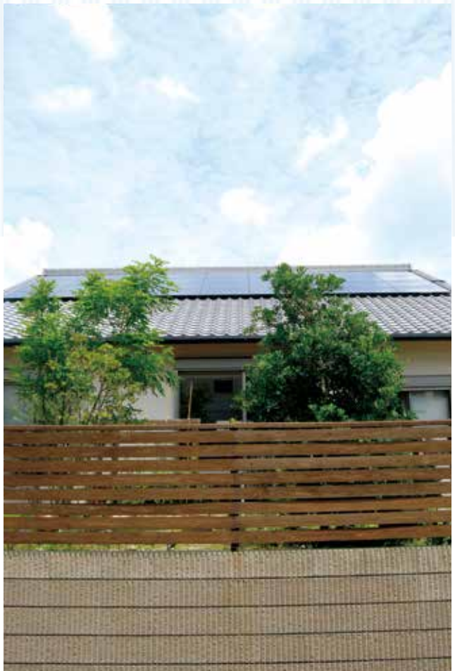
南向きの屋根を利用した太陽光発電パネル。
